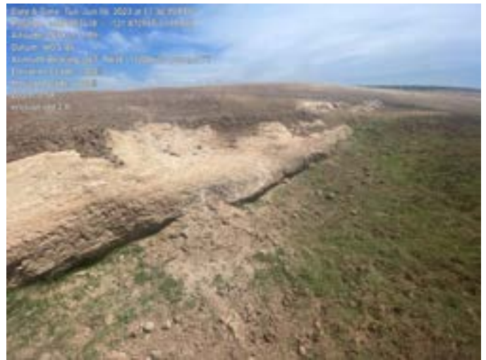
TH002828.JPG 104: erosion old 2 ft
