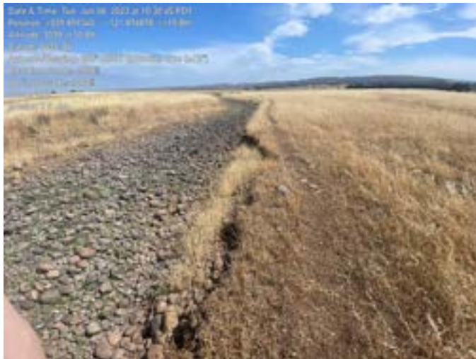
TH002787.JPG 63: erosion 3 ft old
