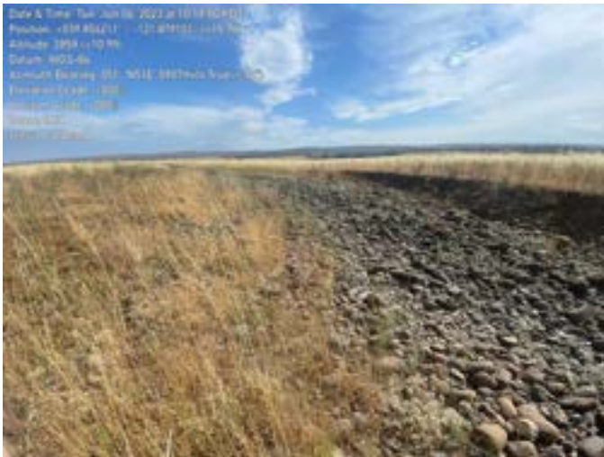
TH002775.JPG 51: erosion at bend
