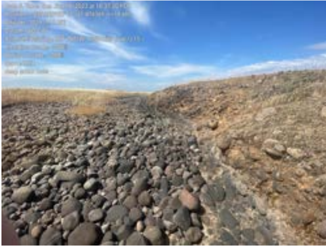
TH002797.JPG 73: deep scour hole
