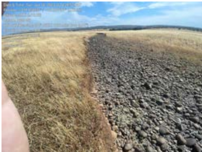
TH002783.JPG 59: erosion 3 ft
