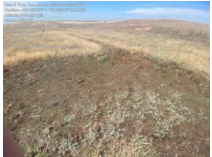
TH002836.JPG 112: low point ds dam fine material no veg
