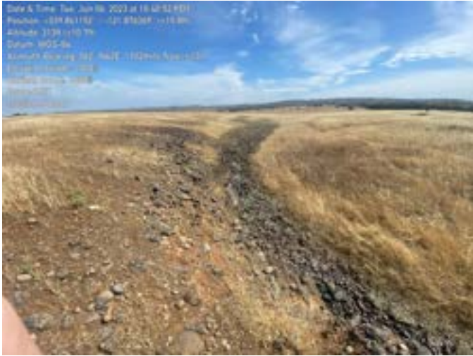
TH002803.JPG 79: erosion of bank
