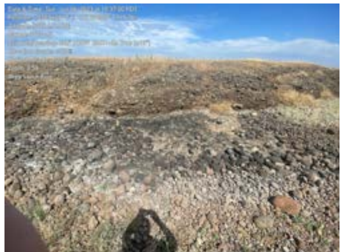
TH002796.JPG 72: deep scour hole
