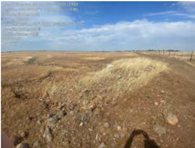
TH002745.JPG 21: DS CULV
